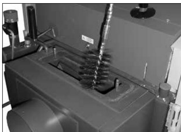
Ukázka čištění kouřového kanálu (CxxST, C50S - trubkovnice) drátěným kartáčem - vrchní víčko
